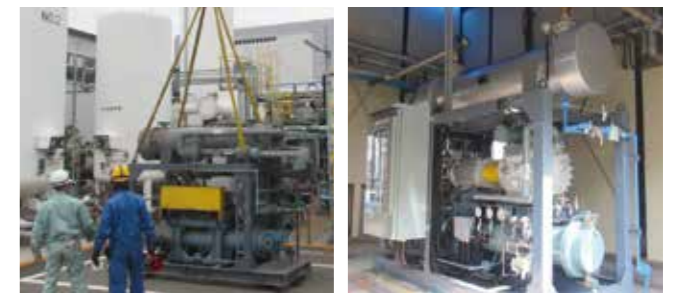
フロン冷凍機更新工事
