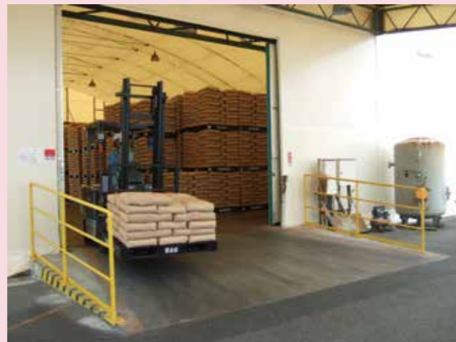
倉庫出入口スロープに設置した安全柵
