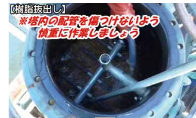
樹脂抜き出し作業のマニュアル
