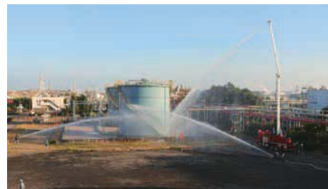
加古川工場 放水訓練
