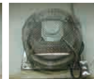
改善後/金網により隙間改善
