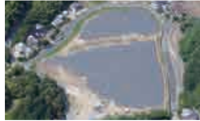
吉名メガソーラー発電所
