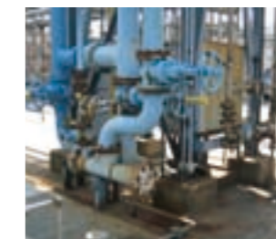
工業用水配管類 改善前
