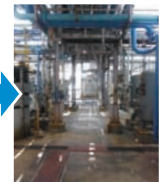
作業道路 改善後
