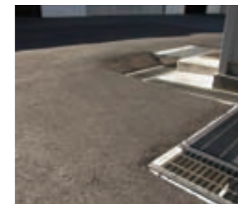
構内路面舗装および排水溝の改善工事の結果
