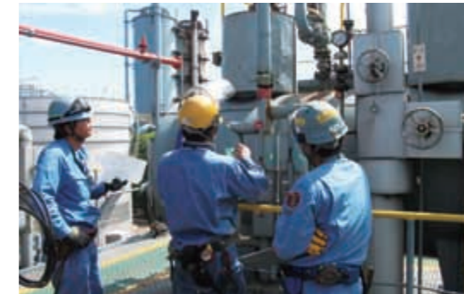
工事を安全に施工するために設備を使用する部署、工事を計画する部署、工事を実施する協力会社の三者による現地のバルブのロックなどの安全対策
