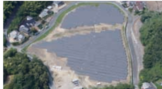
吉名メガソーラー発電所
