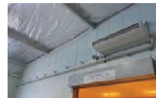
遮熱シートで輻射熱抑制
