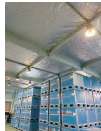
アークアラ倉庫への遮熱シート導入
