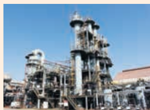
加古川工場液安設備
