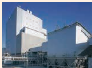
神戸発電所 排煙脱硝装置
